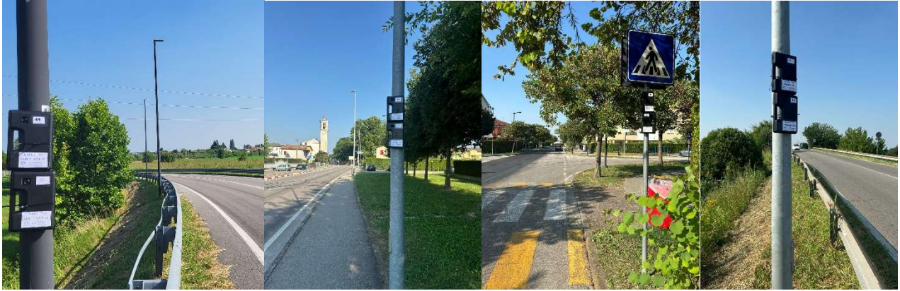
Figura 16. Installazione dispositivi video contatraffico.
